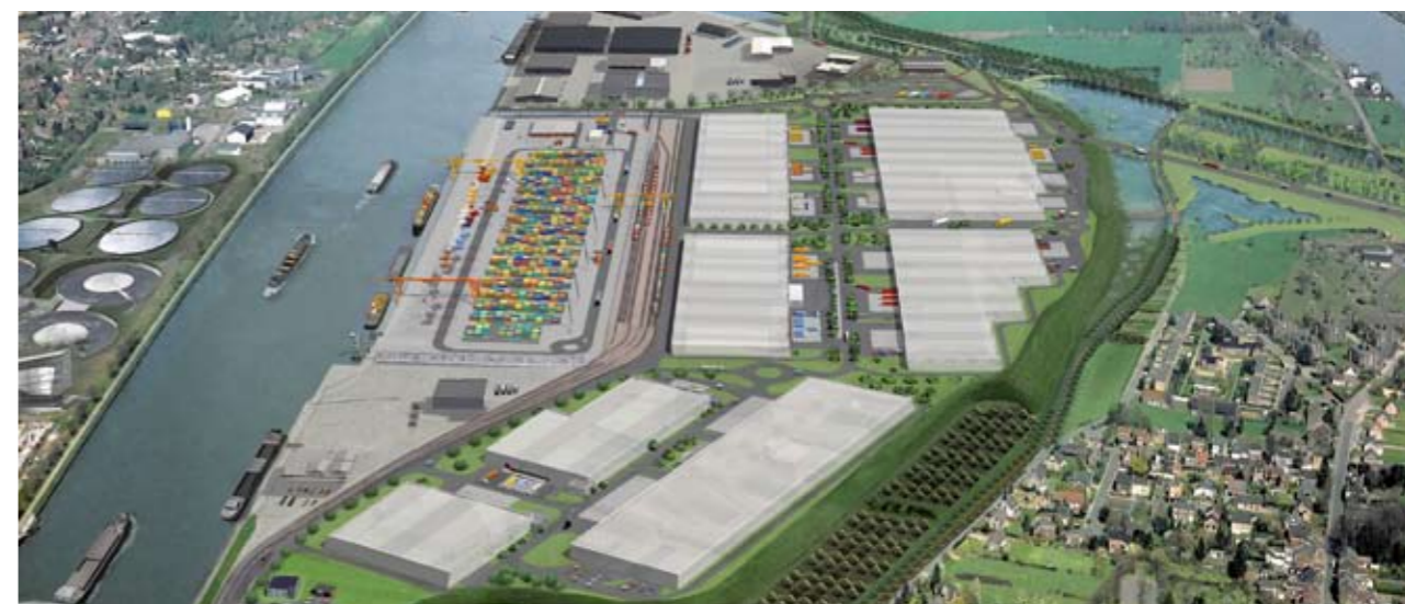
Luftraum / Vue aérienne de la plate-forme Trilogiport © Expérience Image Logistics in Wallonia
