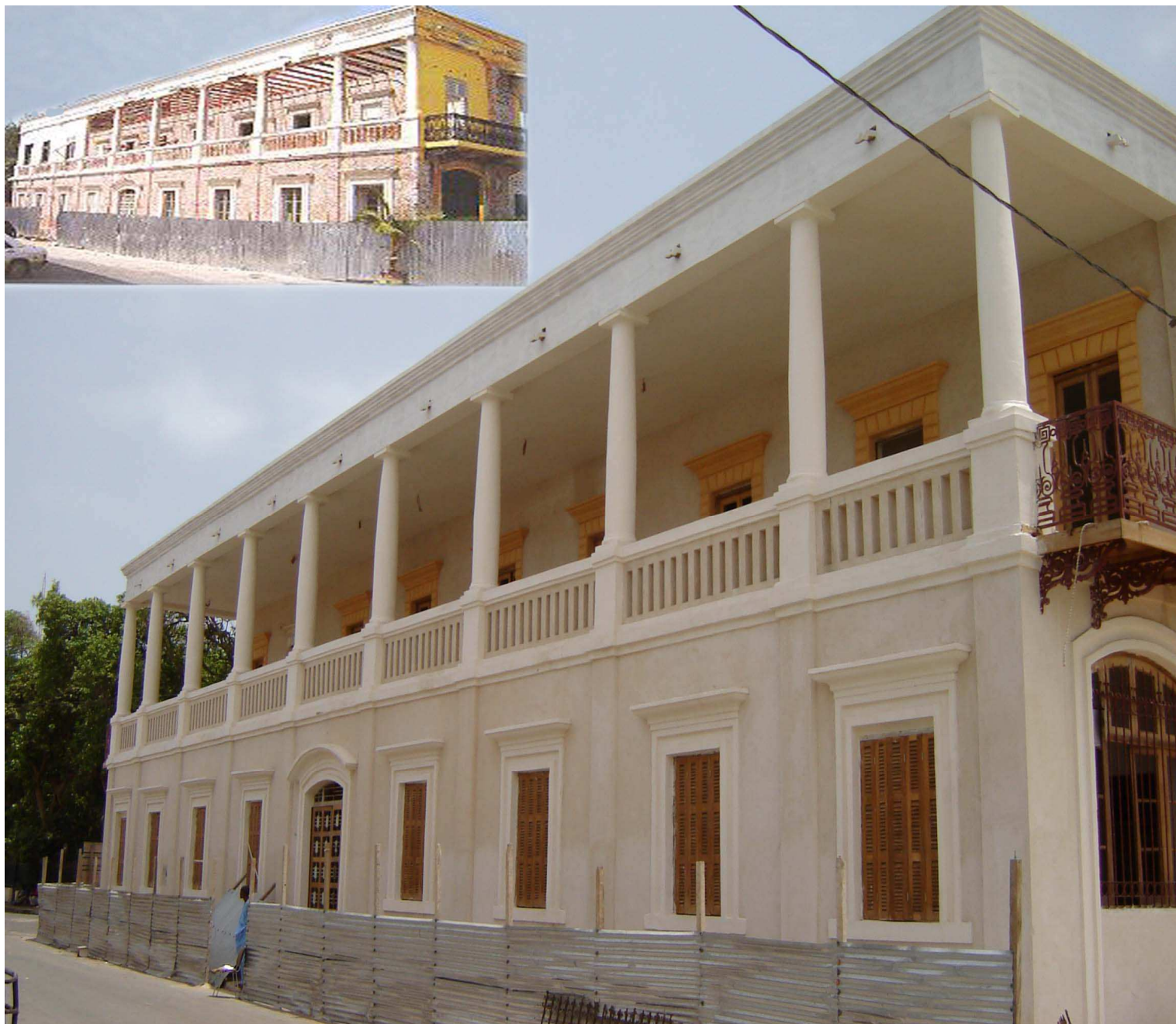
Ancienne Assemblée territoriale du fleuve de Saint-Louis avant et après la restauration assurée par l'Institut du Patrimoine Wallon de 2006 à 2009.
