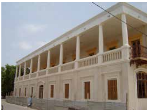
Restauration de l'ancienne Assemblée territoriale du Fleuve à Saint-Louis en 2009
