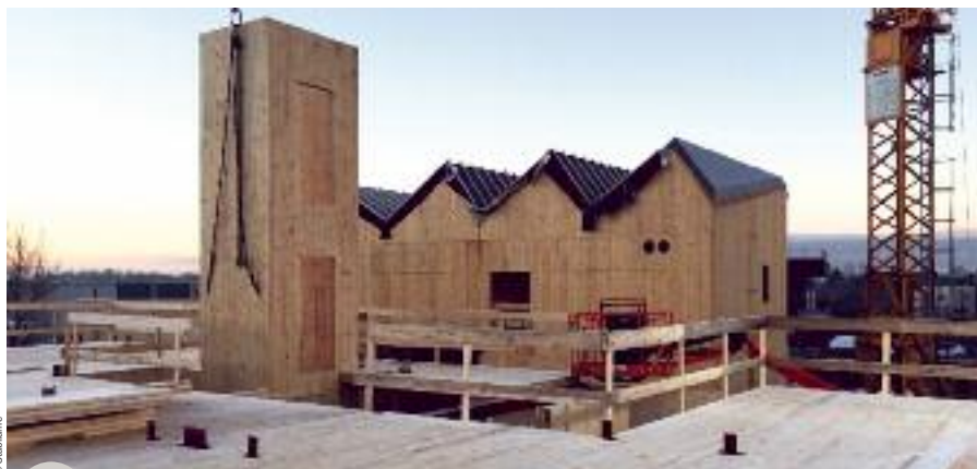
Montage d'un hôtel à cinq niveaux avec la technologie de Stabilame
