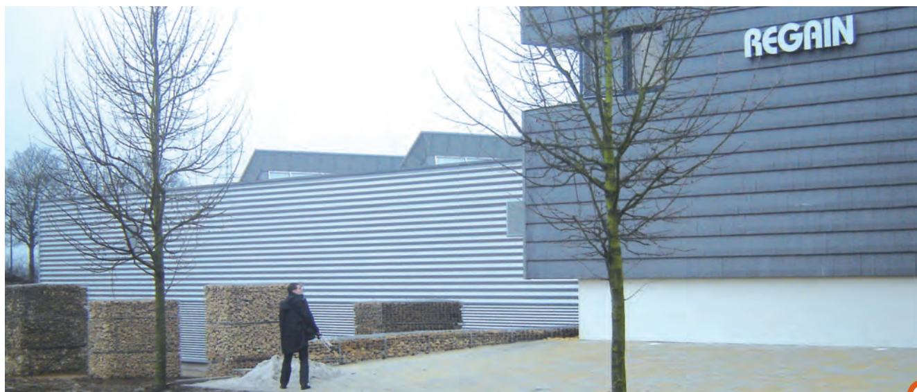
Le bâtiment industriel relais se caractérise par sa haute performance énergétique
