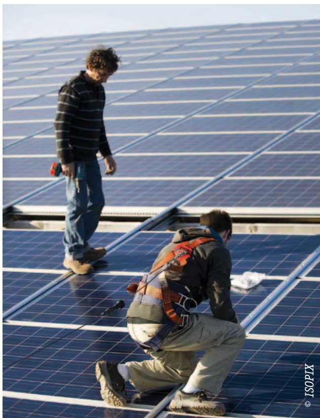
Installation de panneaux photovoltaïques
