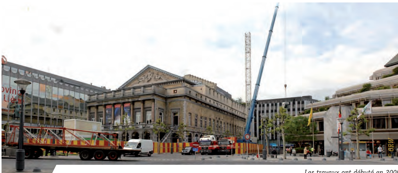
Les travaux ont débuté en 2009
