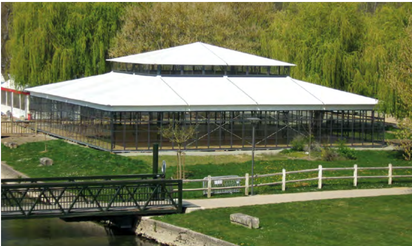
Orangerie de Montbazon © SpanTech
