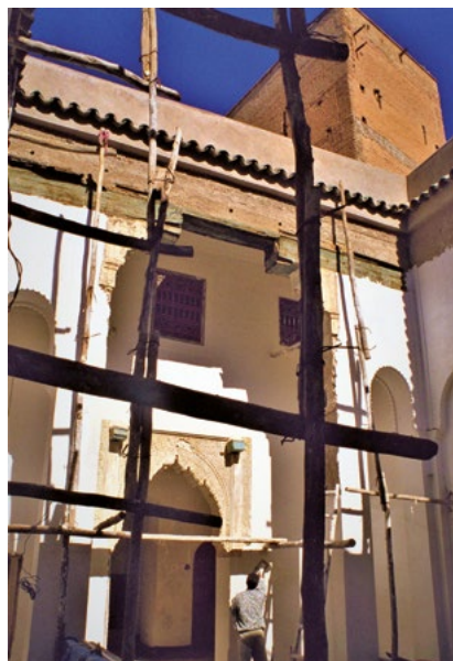
Comme le montre le riad Dar Kawa sous les échafaudages, c'est une rénovation artisanale qui est privilégiée
