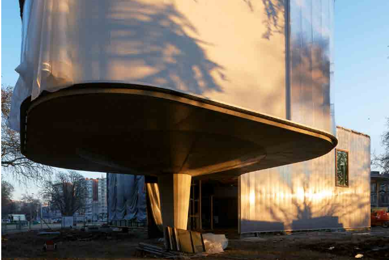
Vue de chantier du Trinkhall Museum © Beguin-Massart / Alain Janssens
